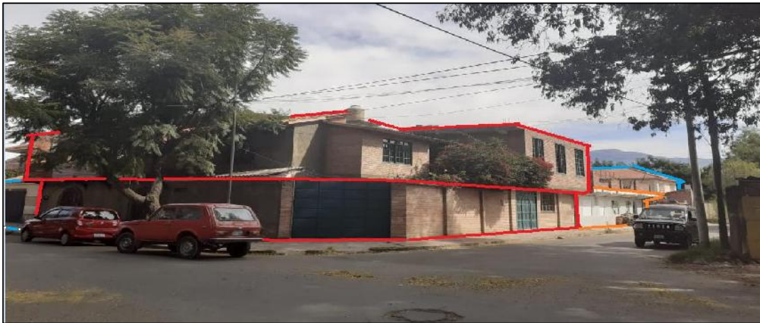
GRÁFICO 11: VIVIENDAS UBICADO FRENTE AL TERRENO SOBRE LA CALLE GODOFREDO ARNOLD ELABORACIÓN: PROPIA
