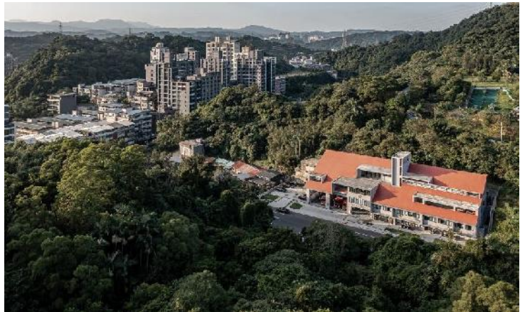
Fuente: Plataforma Arquitectura Estación de bomberos Taiwán
