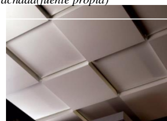
Figura 114- Colocación de panel de cielo falso (Douglas, 2023)
