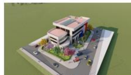
VISTA SUPERIOR PARTE FRONTAL EDIFICIO INE - DEPARTAMENTAL TARIJA
