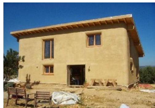
Foto 11 Acabados con materiales tradicionales
