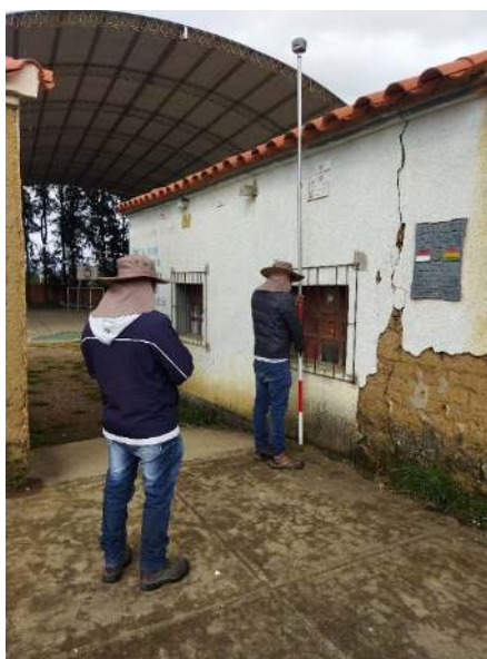
Fotografía 4: Levantamiento topográfico con GPS
