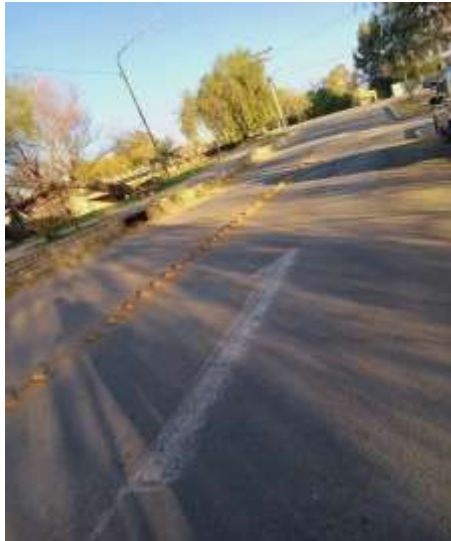
Zona en donde se propone mantenimiento de señalización horizontal
