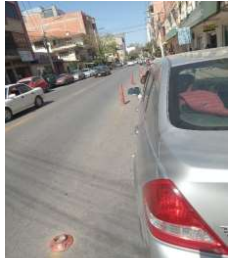
Zona en donde se propone mantenimiento de señalización horizontal
