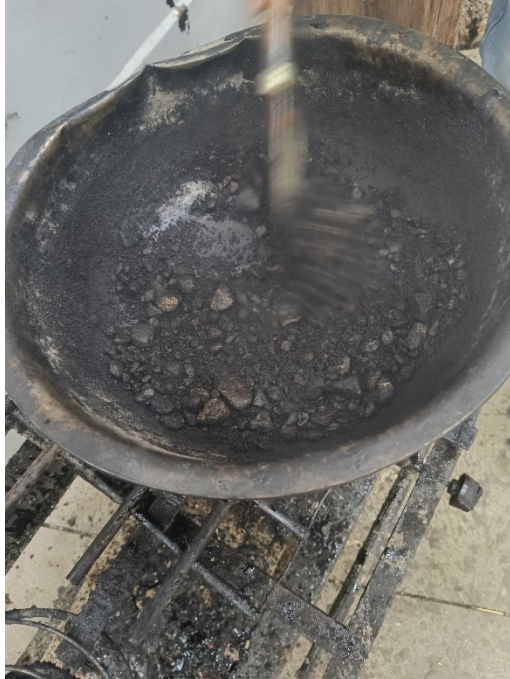
Imagen 31. Preparación de la mezcla asfáltica
