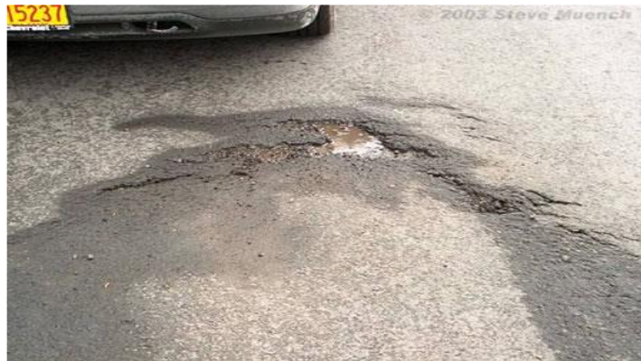
Figura 19. Grietas parabólicas
