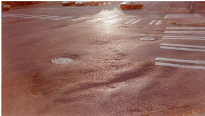
Figura 18. Desplazamiento
