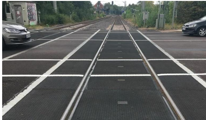
Figura 16. Cruce de vía férrea
