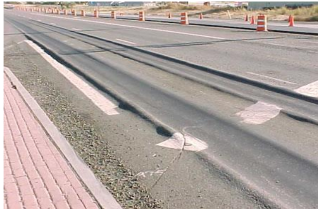
Figura 17. Ahuellamiento
