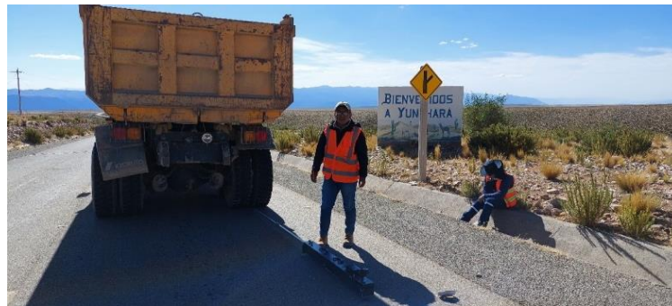
Figura 50. Progresiva final 11+000 (Ida), punto de llegada del ensayo de viga Benkelman
