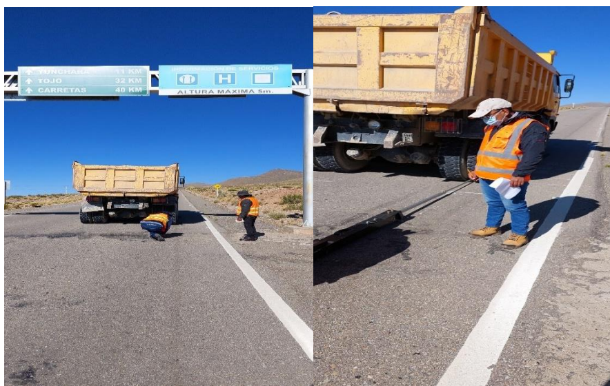
Figura 47. Punto de partida y ensamblado de la viga Benkelman
