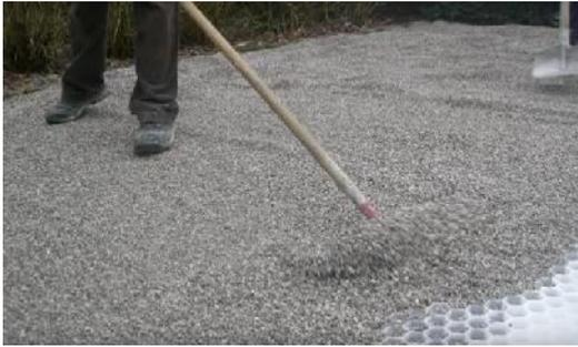
Figura 85. Pavimentos permeables de grava
