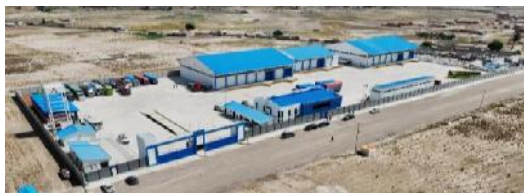
CONSTRUCCIÓN RECINTO ADUANA INTERIOR POTOSÍ- COSTO 18.5 MILLONES BS.
