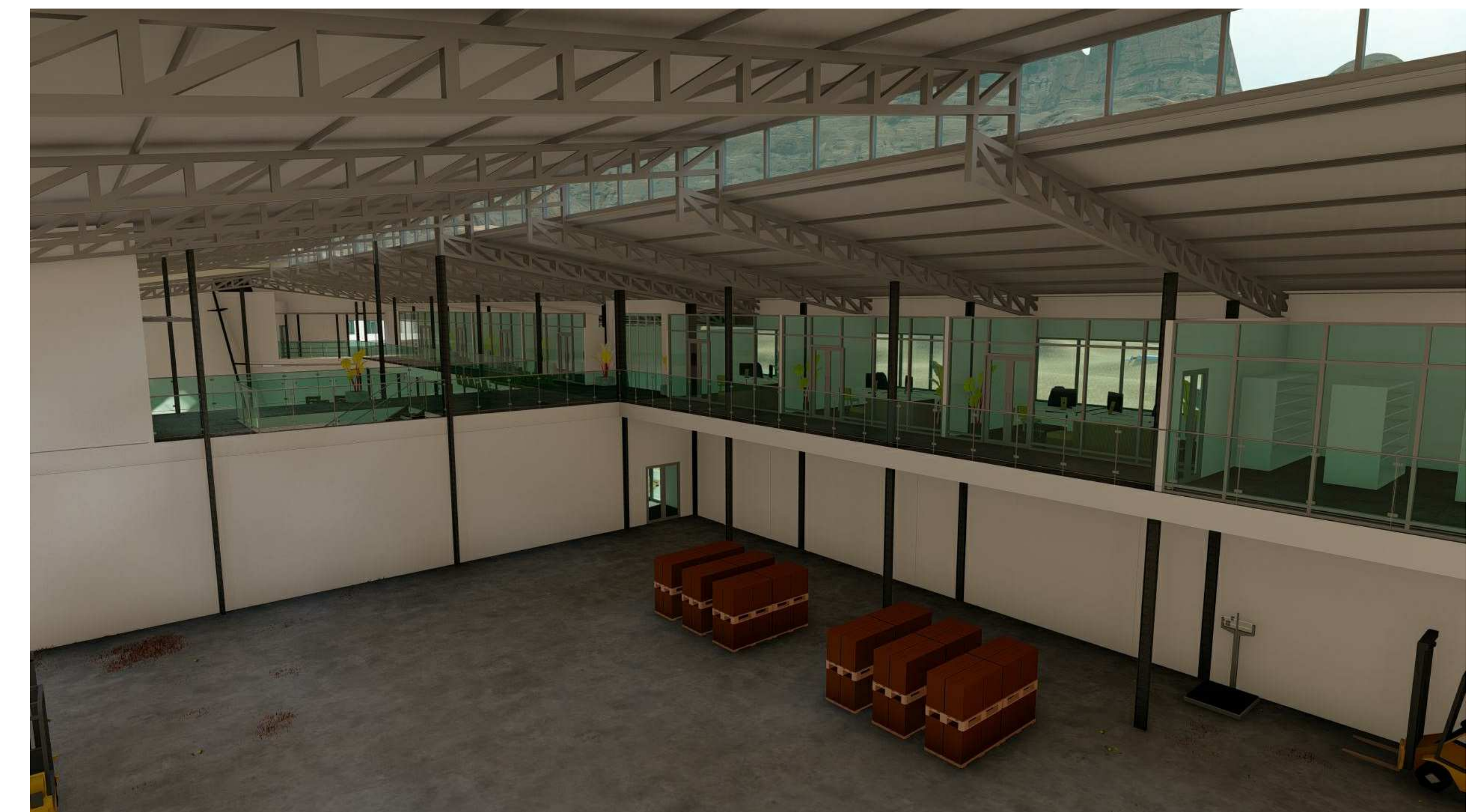
VISTA INTERIOR GALPON DE MERCANCIAS
