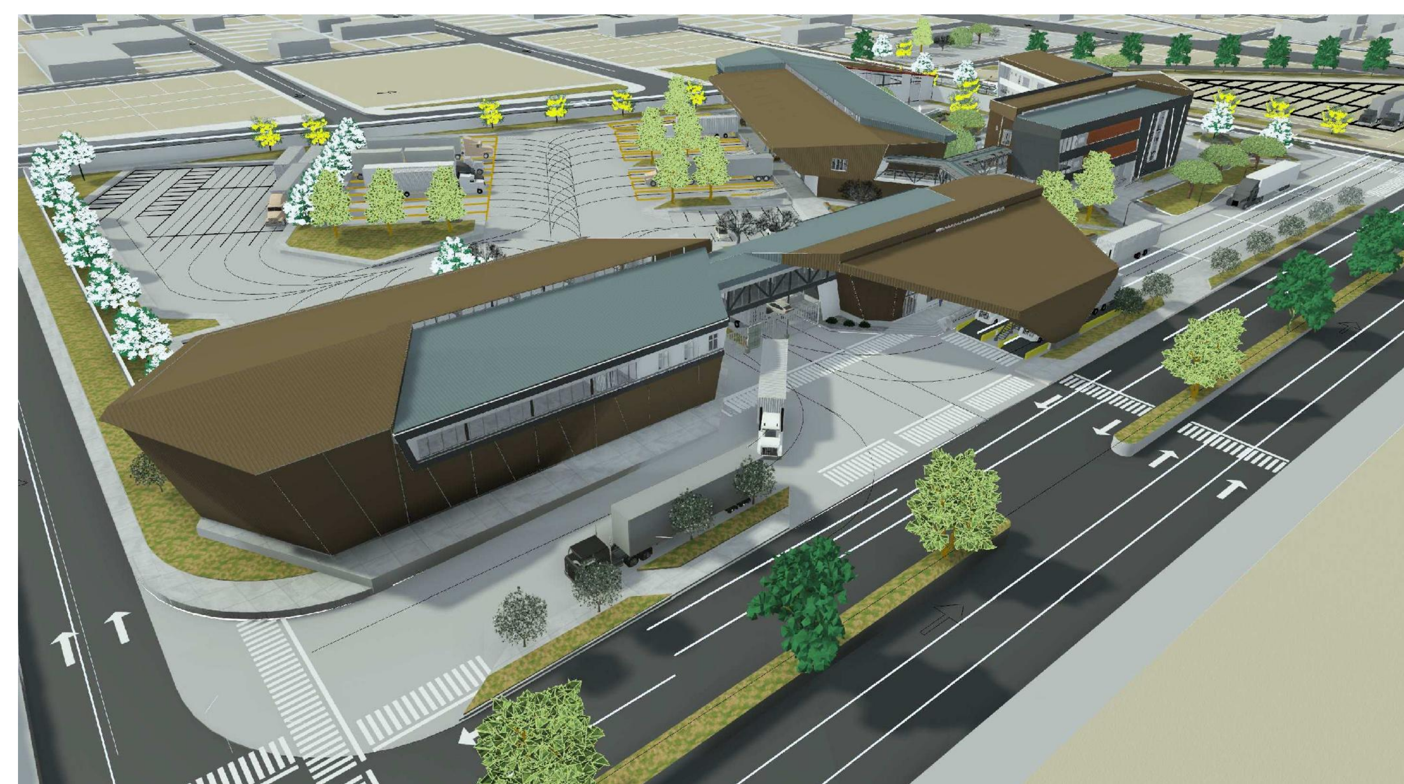
VISTA EXTERIOR NOR OESTE
