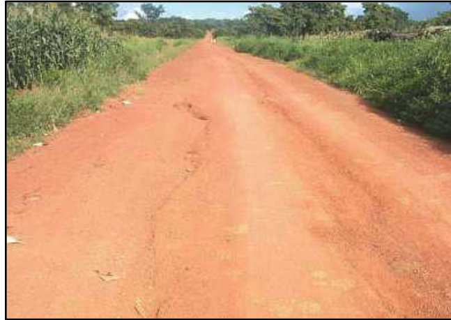
Figura 31. Surcos longitudinales
