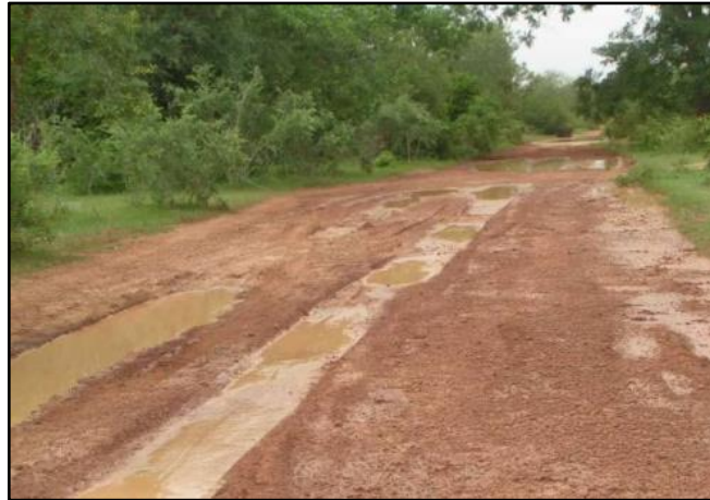
Figura 27. Ahuellamiento
