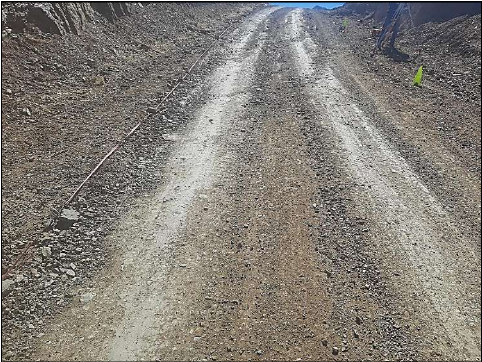
Surcos transversales UM. 8, Tramo San Pedro de Buena Vista – Sella Quebradas
