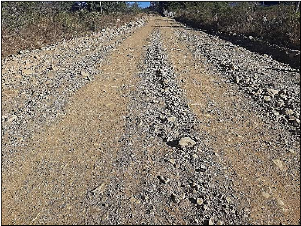
Agregado suelto, UM. 14, Tramo Bella Vista – Pinos Sud
