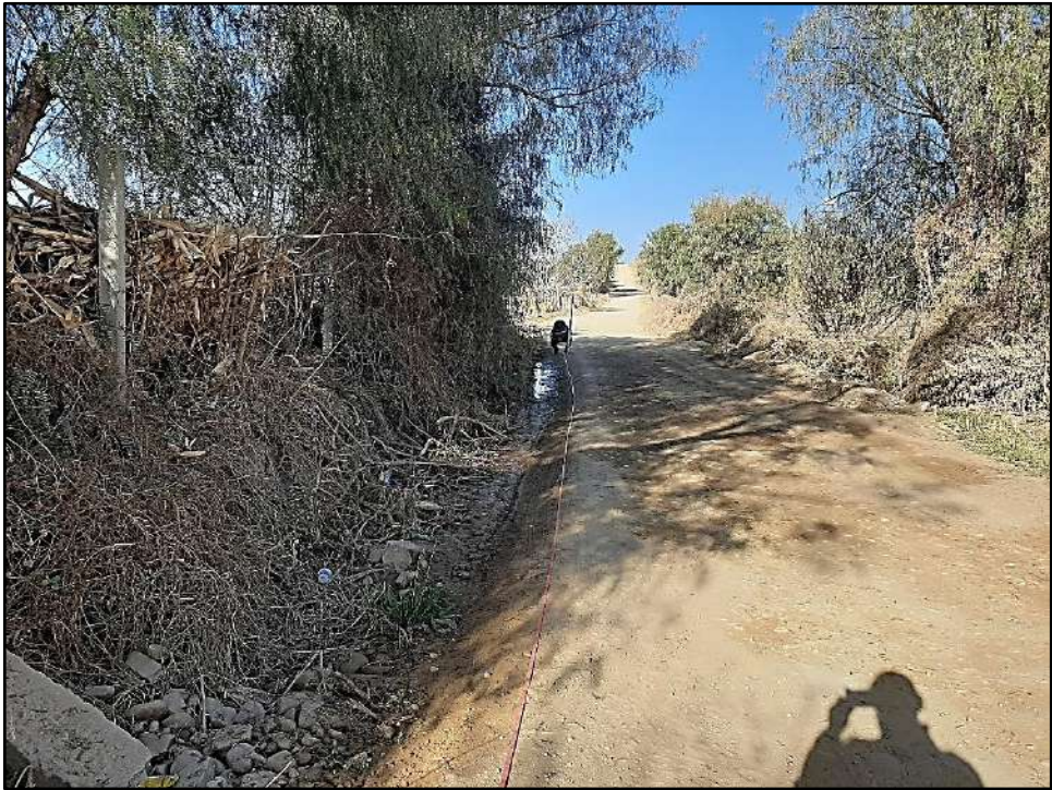
Drenaje lateral inadecuado, UM. 3, Tramo San P. de Buen Vista – Sella Quebradas
