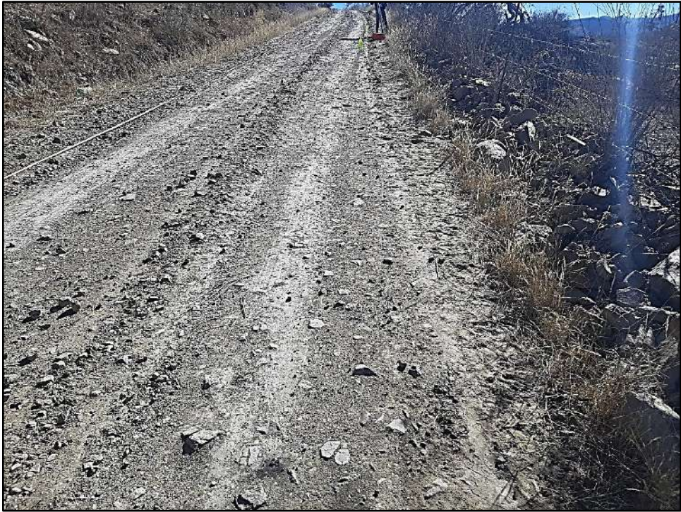
Drenaje lateral inadecuado, UM. 3, Tramo San P. de Buen Vista – Sella Quebradas
