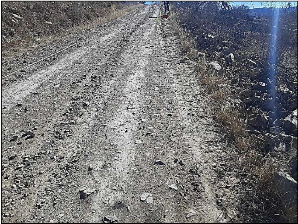
Bombeo, UM. 3, Tramo San Pedro de Buena Vista – Sella Quebradas
