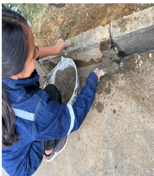
Reparación del cordón con el mortero
