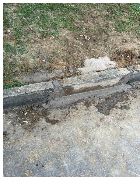
Refacción completa del lugar de extracción de la muestra
