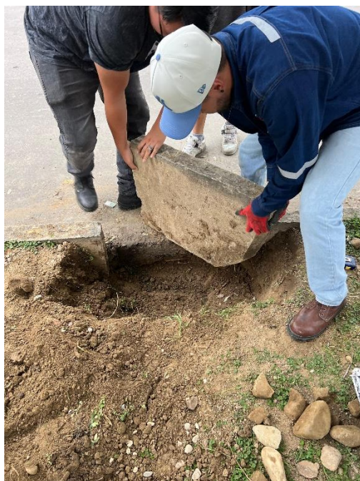
Colocado del cordón
