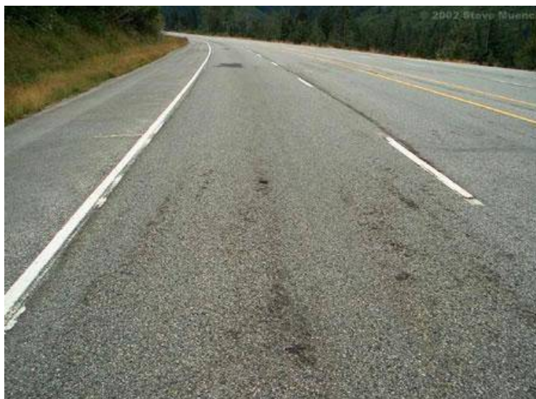
Figura 2.26: Disgregación
