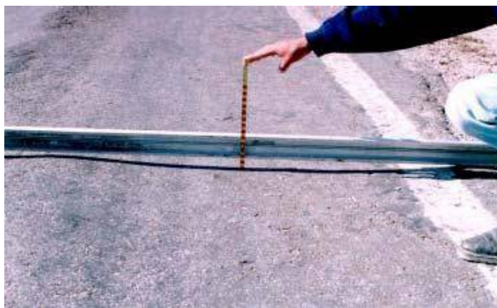
Figura 2.21: Ahuellamiento
