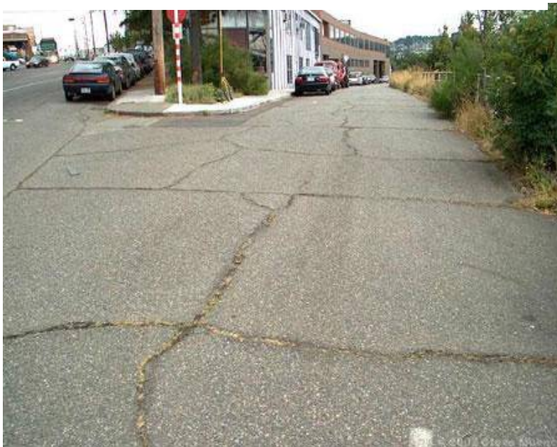
Figura 2.15: Reflexion de junta
