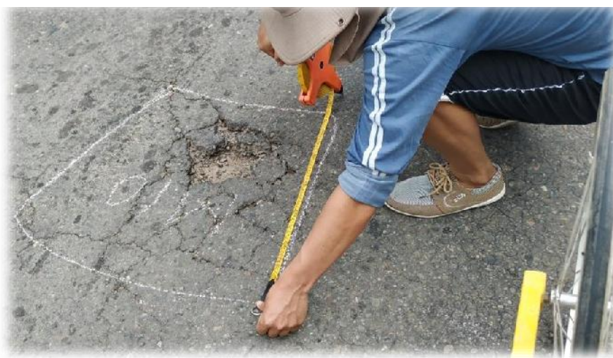
Figura 3.8: Medición del área de falla (PCI)
