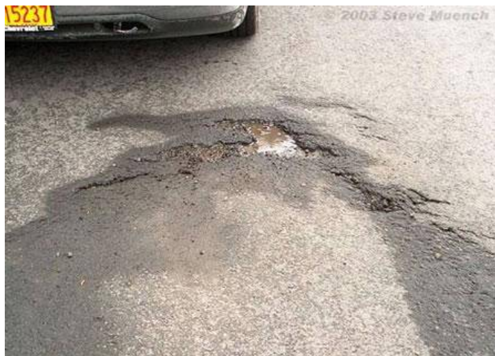
Figura 2.23: Grietas parabólicas
