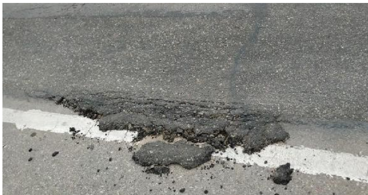
Fotografía 7: Disgregación o desprendimiento de agregados
