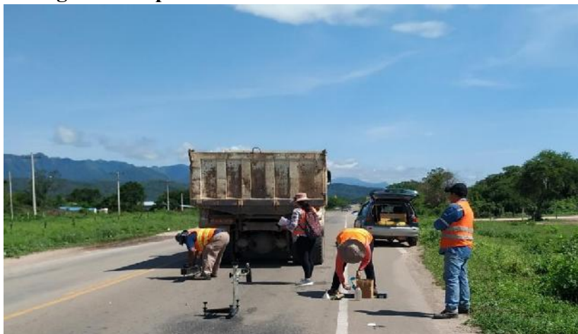
Fotografía 31: personal con chalecos fosforescentes
