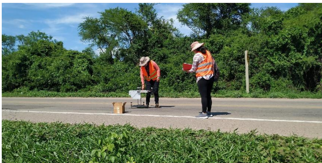
Fotografía 22: Medición del Péndulo de fricción carril vuelta coord. 21°53' 57.23" S 63°37'49.53" O (0+600)
