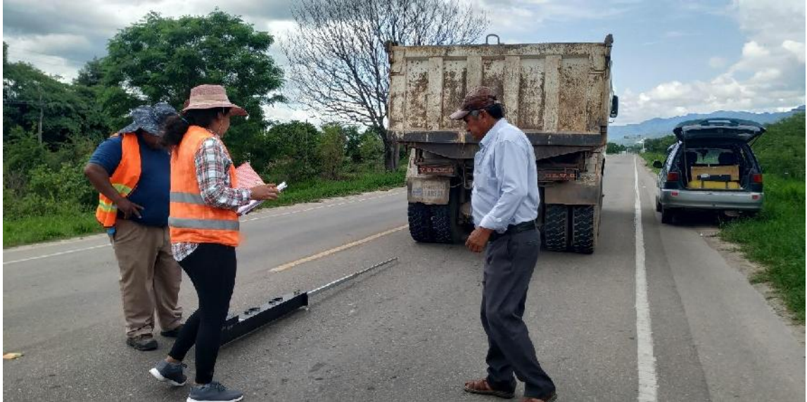
Fotografía 28: lectura de datos Viga Benkelman coord. 21°52'41.84" S 63°37'21.97" O (3+200) carril vuelta
