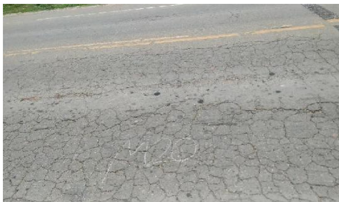
Fotografía 7: Disgregación o desprendimiento de agregados
