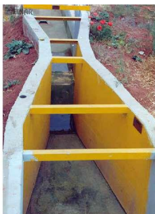
Figura 2.6. Canal Parshall prefabricado (EINAR S.A.).
