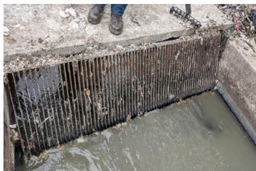
Figura 4.2 y 4.3. Rejilla y cámara partidora.
