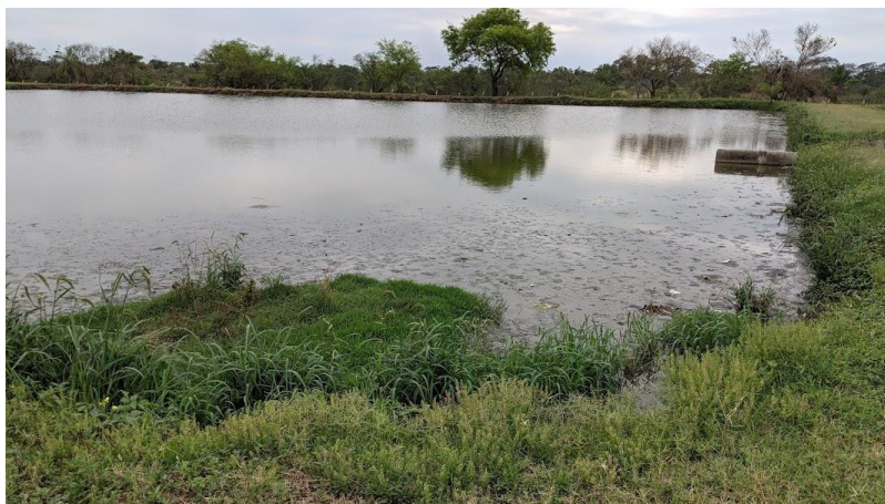
Figura 4.6. Laguna de maduración III.
