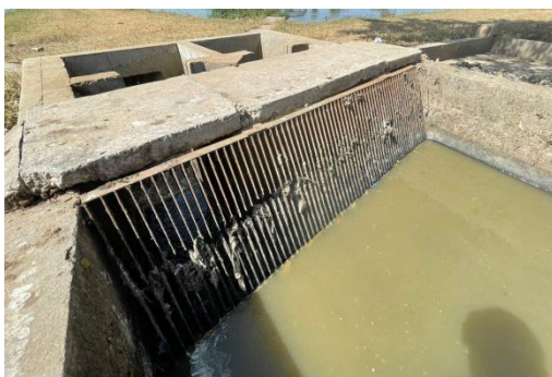
Figura 4.2 y 4.3. Rejilla y cámara partidora.
