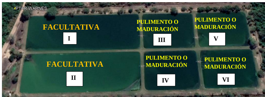
Figura 4.1. Google Earth de la planta de tratamiento Warnes.
