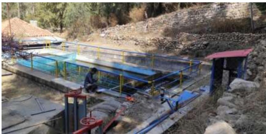
**Figura 4.3** Medición de las dimensiones del desarenador.
