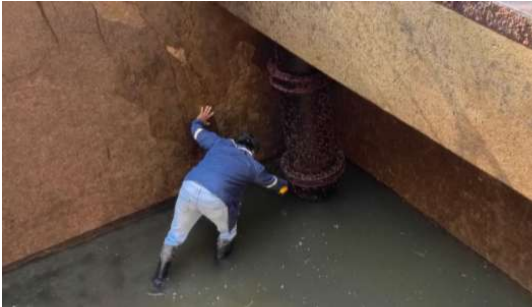
Tubería de desfogue
