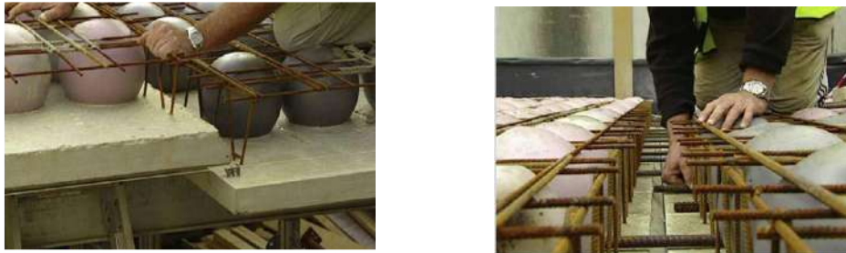
Figura 4.14: Alineación de paneles y colocación de acero de conexión
