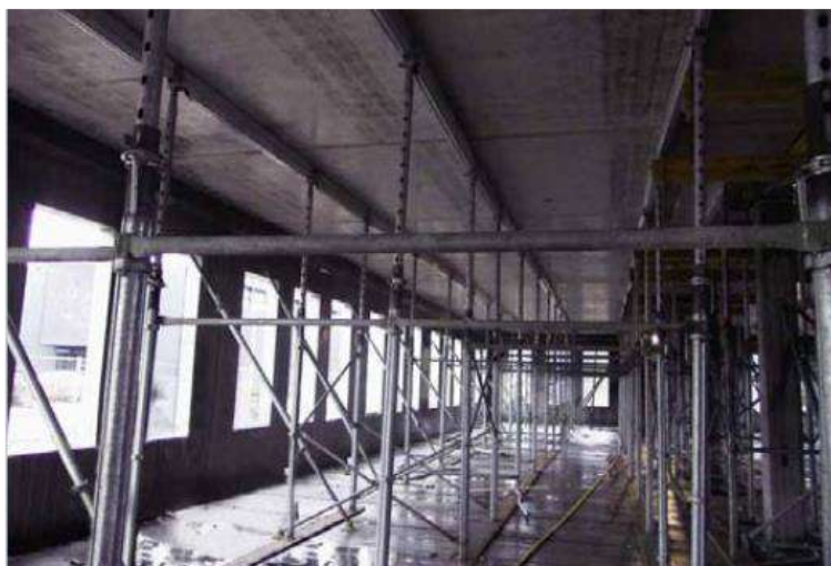
Figura 4.10: Cimbrado de paneles
