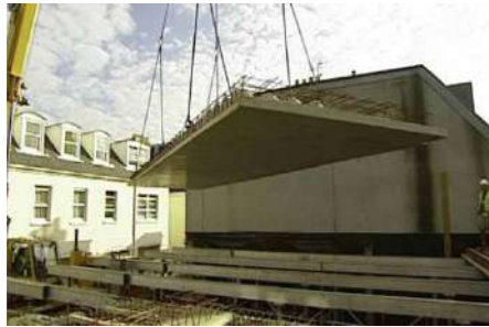
Figura 4.8: Elevación del panel
