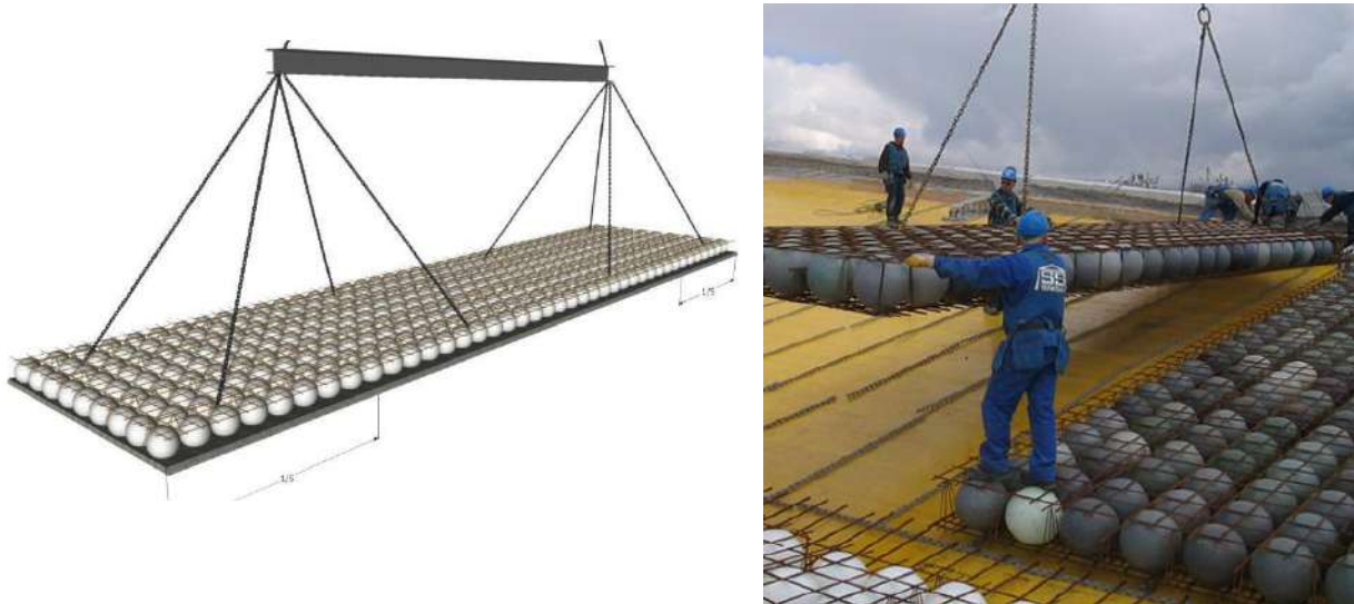
Figura 4.9: Procedimiento correcto de izaje para los paneles
