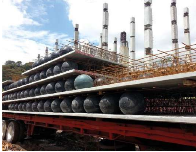
Figura 4.6: Transportación de los paneles
