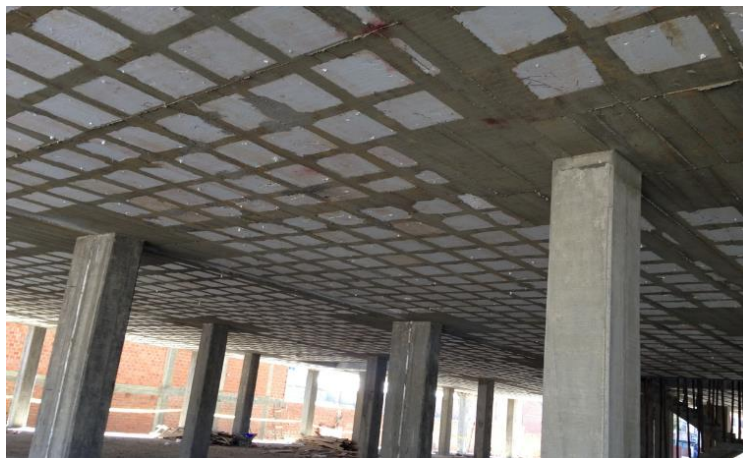
Figura 4.2 Losa casetonada con vigas planas
