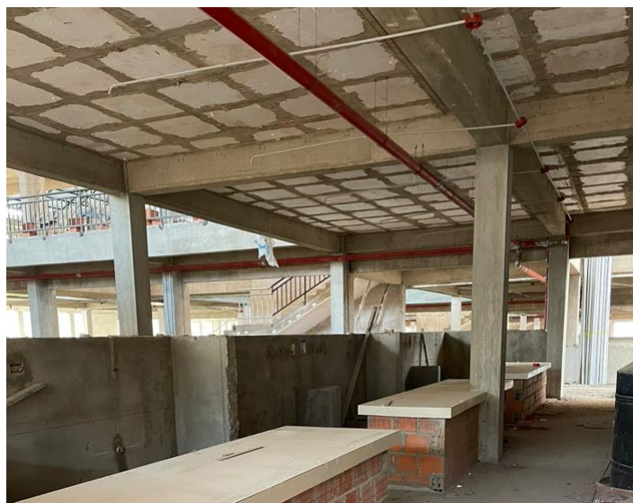
Figura 4.1 Losa casetonada con vigas peraltadas
