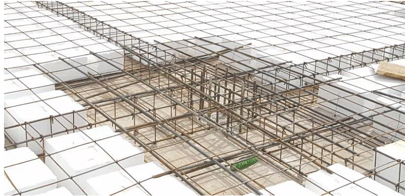
Figura 4.3 Armado del ábaco
