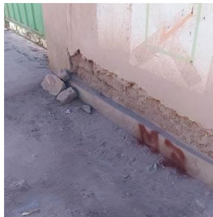
Identificación de vivienda.
