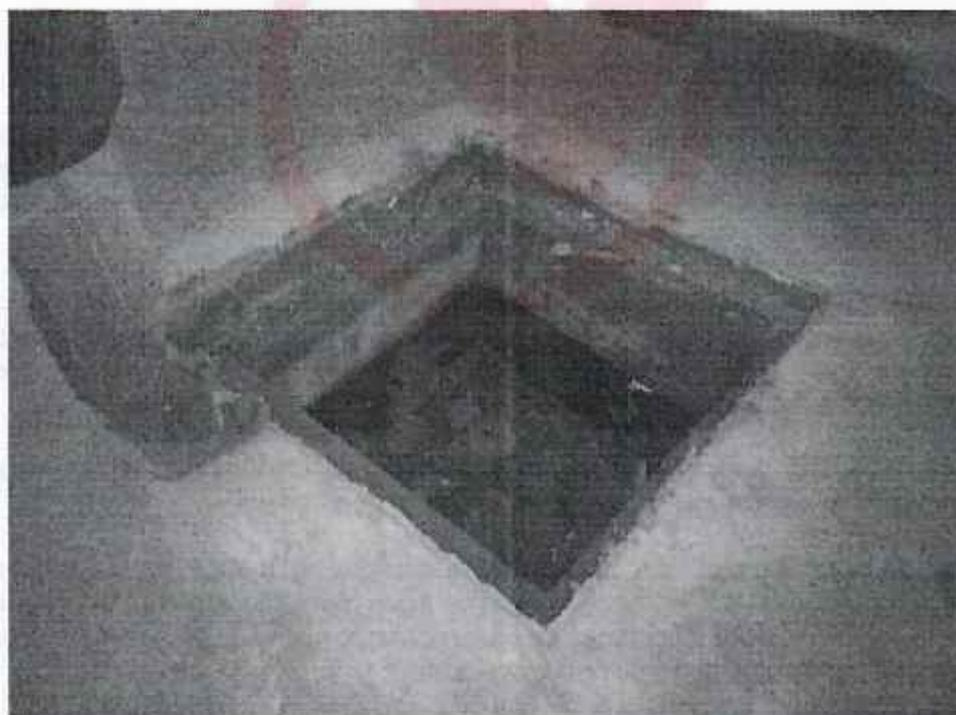
**Figura 24 - Pozo en desuso, dentro de cámara de inspección inundada con agua contaminada con aceites y grasas. (Cochabamba)**
