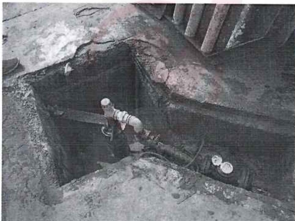
Figura 22 - Pozo dentro cámara inundada con lixiviados (La Paz)
