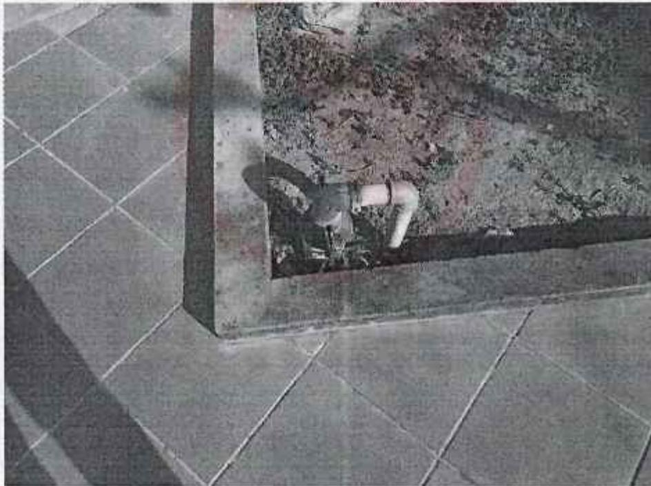
**Figura 20 - Pozo dentro de ambiente sin acceso vehicular, sin elevación, sin protector (Santa Cruz)**
