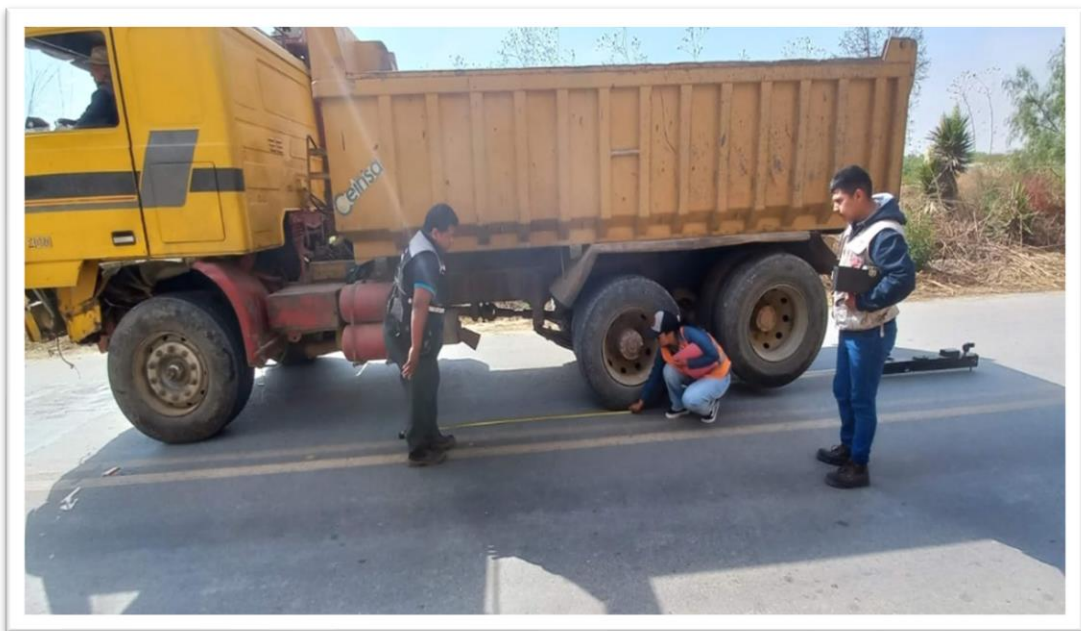
FOTOGRAFÍA 2. EVALUACIÓN ESTRUCTURAL DE LA CAPACIDAD DE SOPORTE DE LAS CAPAS DEL PAVIMENTO Y LA FUNDACIÓN.
