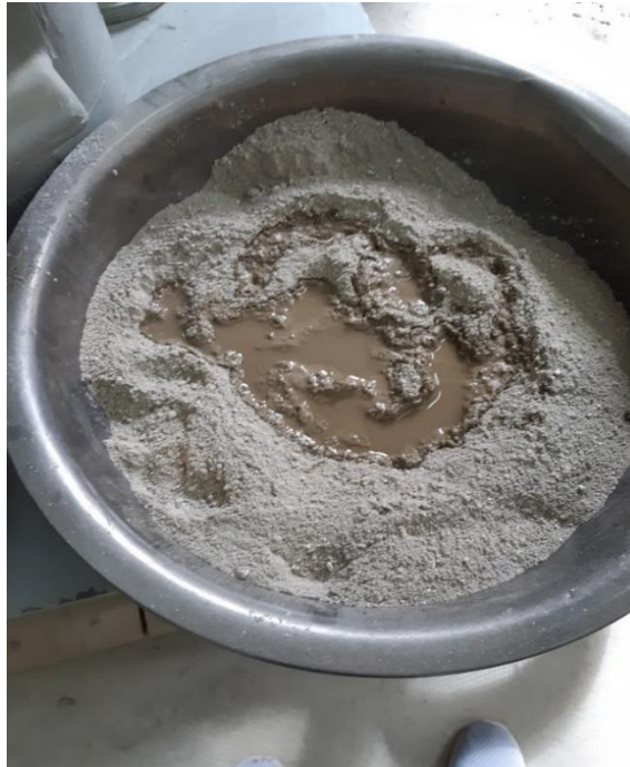
Aplicando el porcentaje de agua para la mezcla (Barrio jardín)
