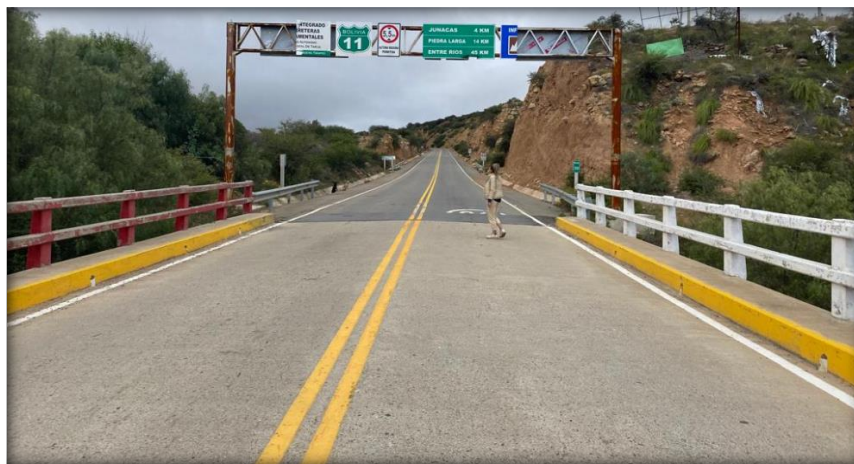
Inicio del tramo
