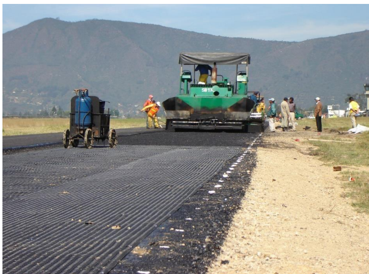
Ilustración 21: Colocado de geomallas
