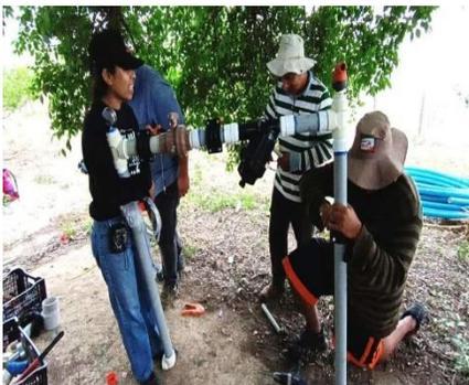
Armando el cabezal (manómetro, válvula de aire, filtro, fertirriego)
