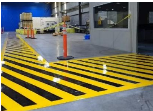
Señalización de pasos peatonales
