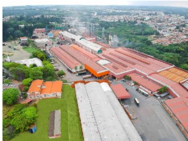
Ilustración 11 Utilización de la Calamina y el Hormigón
