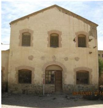
**Revoque:** El revestimiento que protegen y cubren a los muros de la edificación interna y externa está elaborado de masa (tierra, agua y paja).
