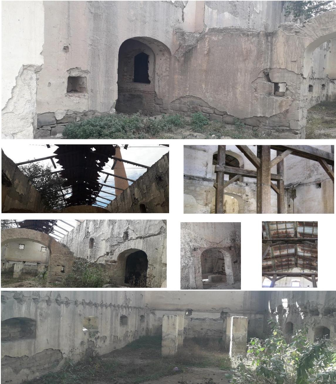
Figura 7. Estado de deterioro de la infraestructura (interior)
