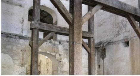
**Cubierta:** La cubierta consta de dos materiales importantes, una estructura de madera y calamina con parapetos de barro, paja y ladrillo macizo tradicional además su estructura interna cuenta con tensores de cables.
