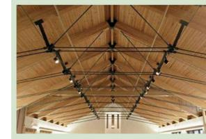
Cubiertas de viga de madera reforzada con tensores y el techo se implementara teja colonial o de pvc.
