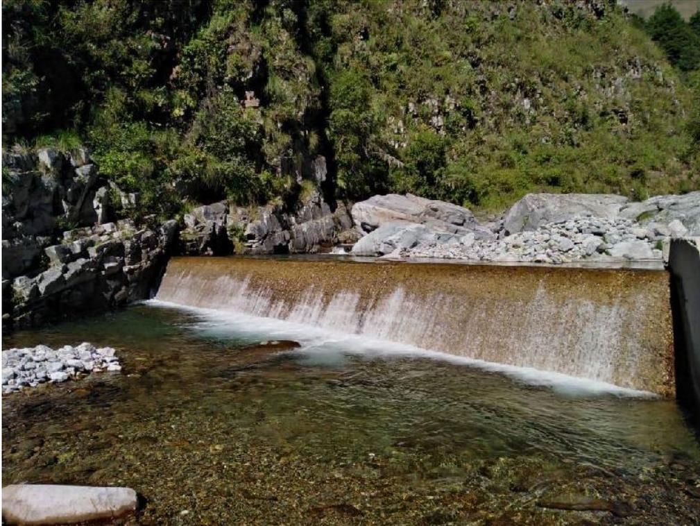
**Fotografía 4.2 Presa derivadora del sistema de agua potable**
