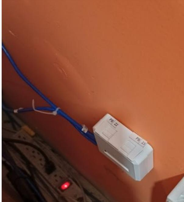
Figura 97. Vista de la instalación de las rosetas en las oficinas
