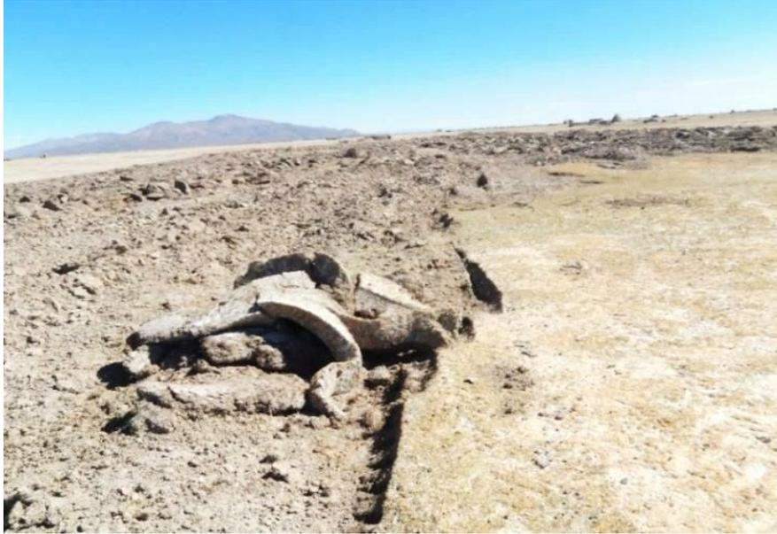
**FOTOGRAFIA N° 22:** Imagen de Presas de morrillos para evitar la erosión de surcos y cárcavas.
