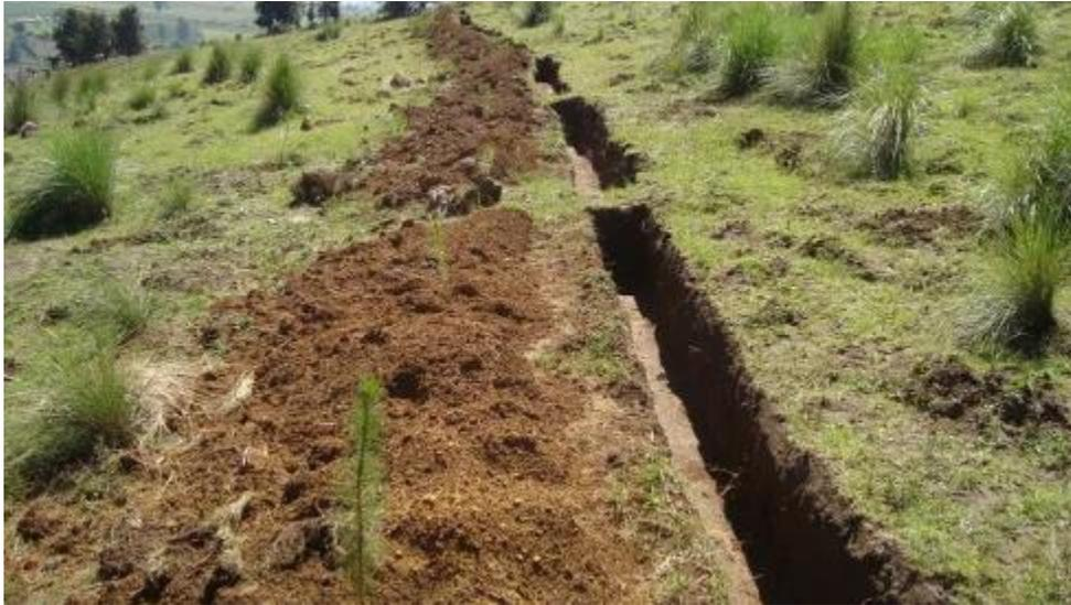
**FOTOGRAFIA N° 24:** Zanjas realizados con geocostales
