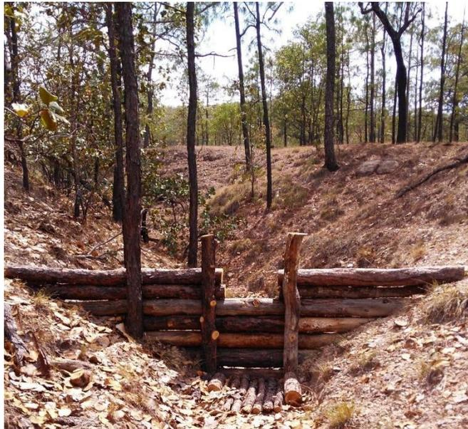
**FOTOGRAFIA N° 23:** Zanjas de infiltración que se pueden realizar en la zona media y alta del área de estudio.
