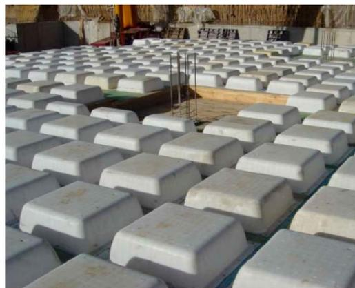
El aligeramiento de la placa se consigue colocando casetones en las zonas de menores esfuerzos cortantes, dejando entre ellos los nervios resistentes en las dos direcciones. Dichos casetones pueden ser de dos tipos: A-Recuperables: Moldes plásticos que se retiran junto con el encofrado. B-Perdidos: Bloques huecos de hormigón o bloques de poliestireno, que se colocaran en lugares especificados en los planos y/o indicados por el Supervisor de Obra.
