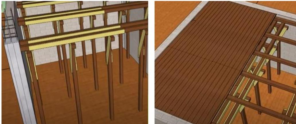
Se realiza el armado del encadenado de cerramiento y el armado de las nervaduras según el cálculo que se realiza por el ingeniero estructurista.
