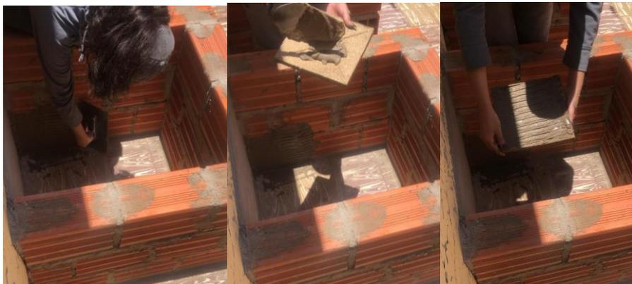
Ilustración 55 Aplicación biomaterial. Fuente: Elaboración propia.
