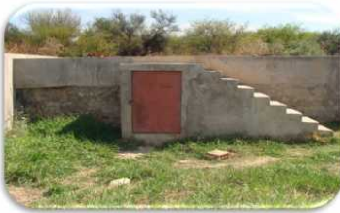
Fotografía 5 Deposito de la PTAR
