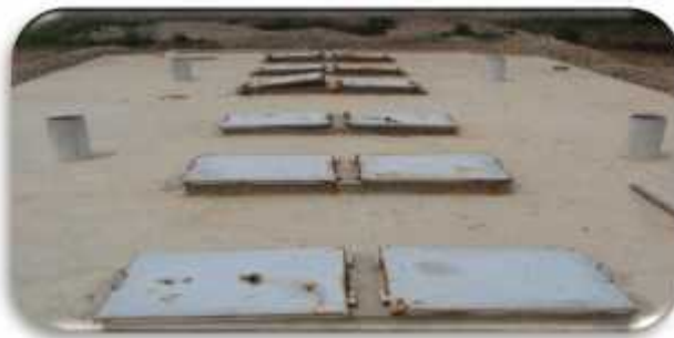
Fotografía 7 Exterior de las Cámaras
