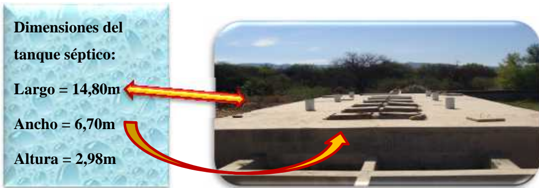
Fotografía 6 Dimensiones Tanque Sedimentador
