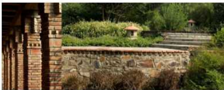
Ilustración 28: Mampostería de piedra y ladrillo. Fuente: https://psdastudio.com/garden-of-five-senses/
