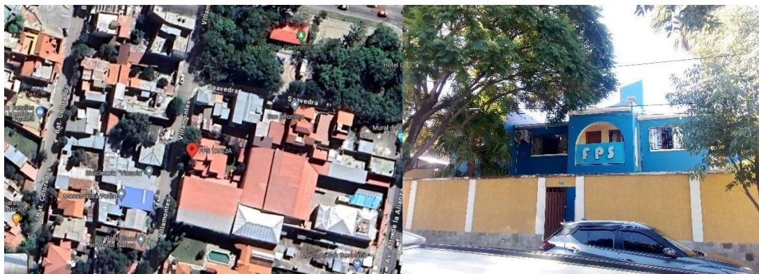
Figura 1 Ubicación de la Infraestructura FPS Villamontes
