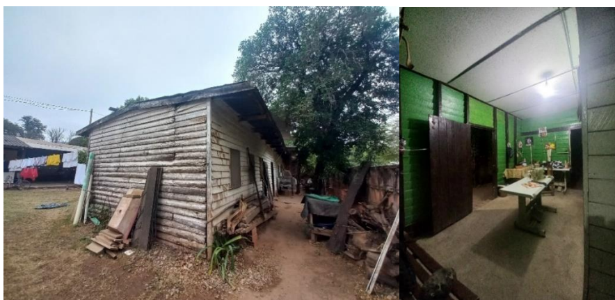
Figura D1 – D1.1 Vivienda con Muros de Madera, Pisos de Cemento y Cubierta de Calamina
