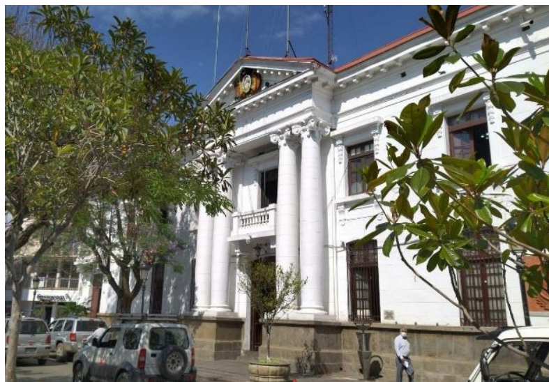
Ilustración 25 Edificio de la Gobernación de Tarija Cercado.
