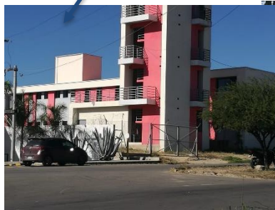
1 Vista de la Estación de Bomberos
