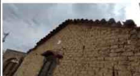
Muro de adobe
