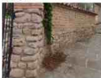
Cimiento de piedra
