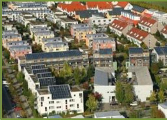
Se propone un sistema centralizado de producción de agua caliente sanitaria y para calefacción, mediante placas de captación solar, distribuidas en diferentes edificios, y la construcción de grandes depósitos comunitarios para su almacenamiento, cuyo gran volumen, se incorpora al lugar recibiendo un tratamiento paisajístico.
