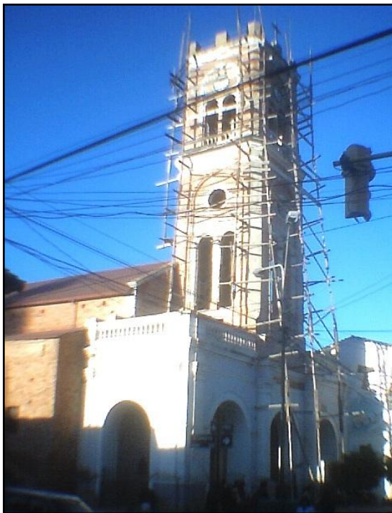
Proceso de Restauración 2006
