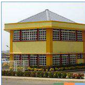
Edificio de Administración
