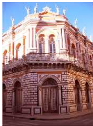
Parte del blindado de la fachada fue con ladrillo.
