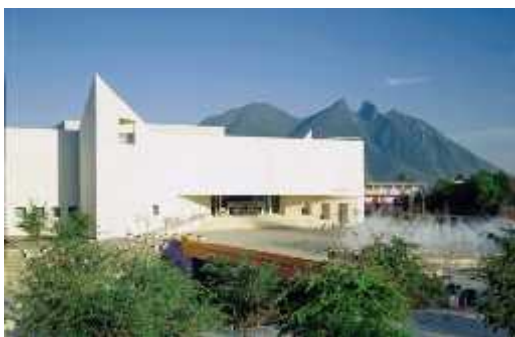
Vista del ingreso principal
