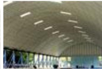
Estructuralmente y estéticamente. El Sistema Arquitectónico de Techo es una excelente estructura con paneles corrugados, los cuales se caracterizan por su auto apoyo, se juntan simplemente para proporcionar protección superior contra los cambios de clima.
