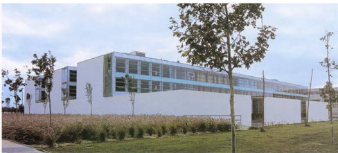
Componente importante en la fachada el vidrio
