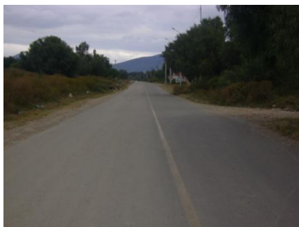
Av. Principal de ingreso al terreno
